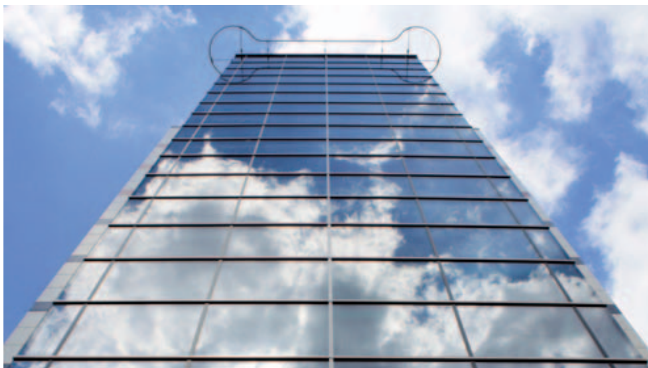
Areál FNM – rekonstruované křídlo C Dětské nemocnice
