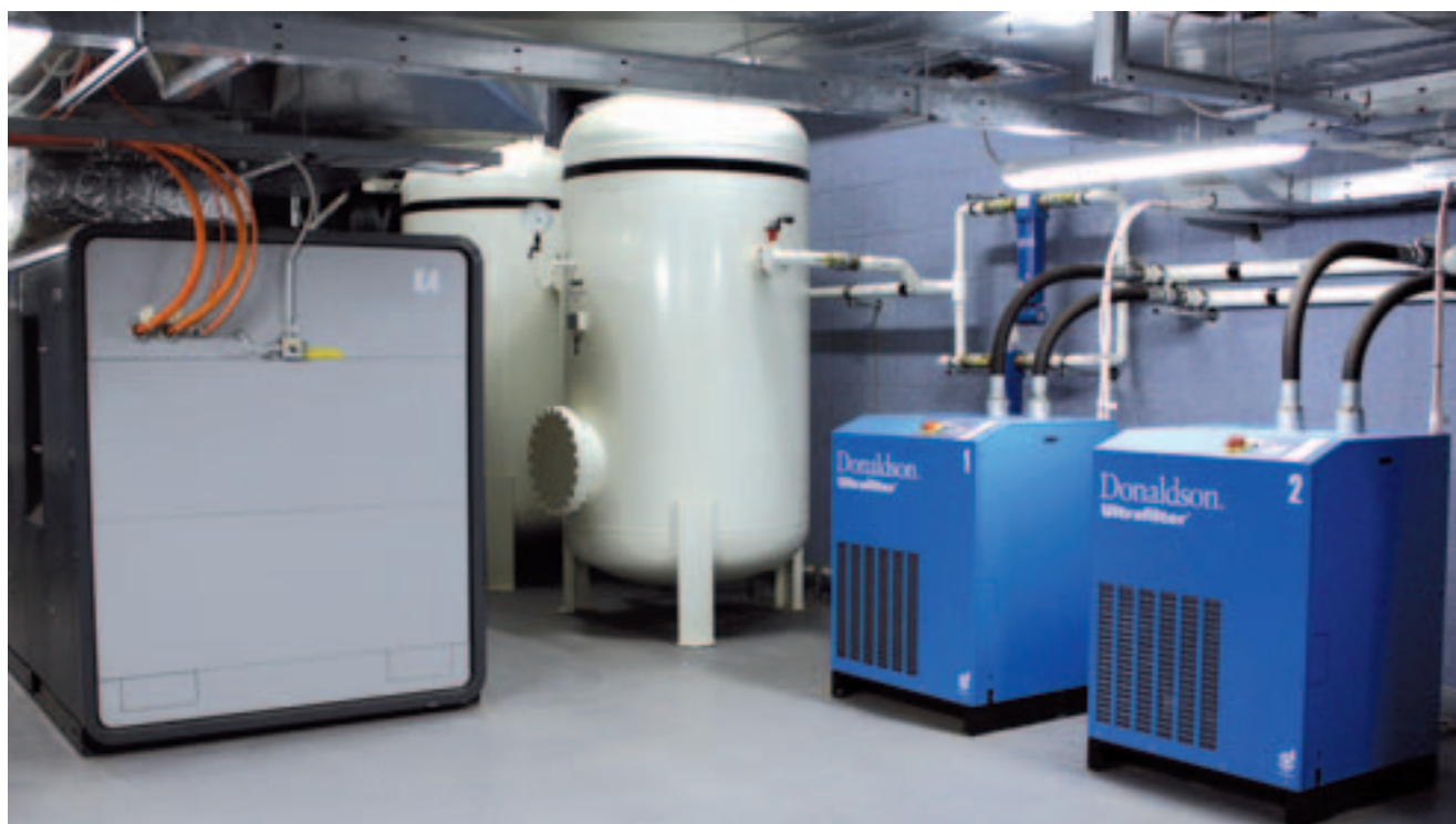
Areál FNM – rekonstruované energocentrum
